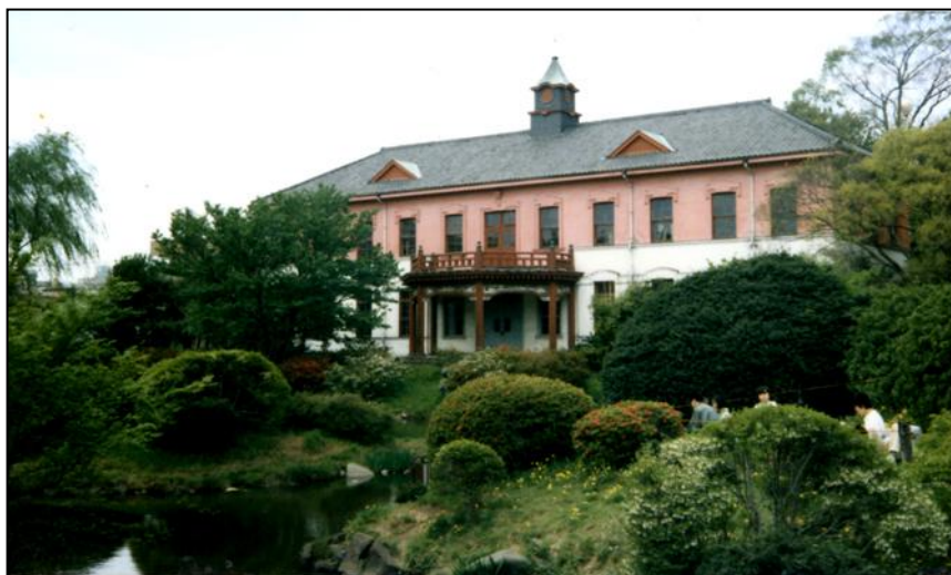
東京医学校本館遺構(1986.4.27 堀江幸司撮影)
